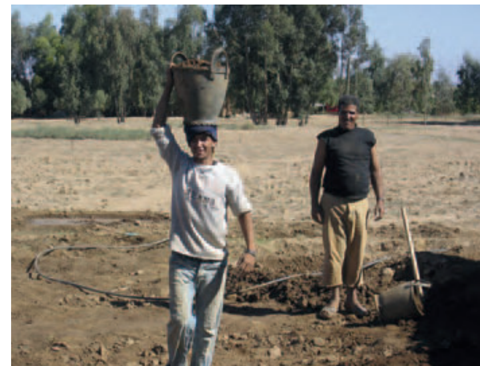
Albañiles preparando el barro para la construcción de una casa de tapial tradicional.
